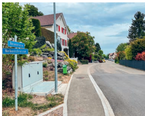
Auf der Rosenstrasse ist aufgrund der Sanierung erneut eine Sperrung notwendig.
