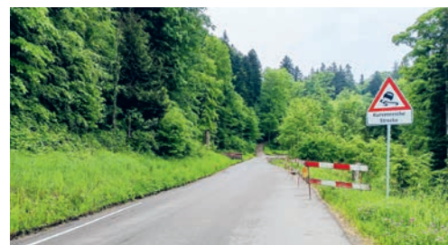
Die Sanierung der Eichstrasse wird im Juni/Juli 2026 weitergeführt.
