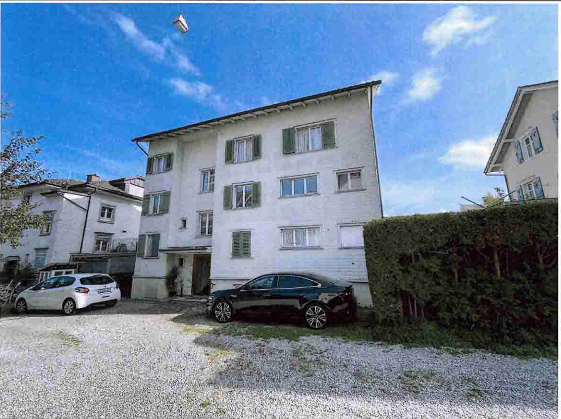
Aussenansicht von Nordwesten
