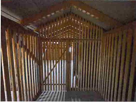
Dachgeschoss: begehbare Estrich
