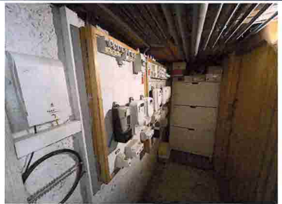
Hauptverteilung Elektrik (altes Tableau)
