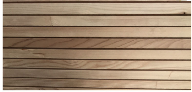
Deckenbekleidung Brettstapeldecke, teilweise mit Akustikfräsungen
