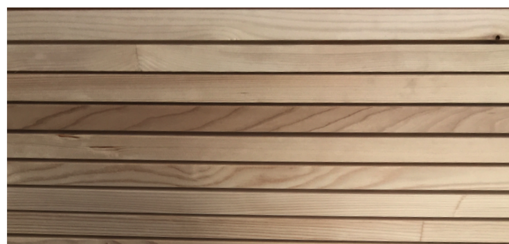
Deckenbekleidung Brettstapeldecke, teilweise mit Akustikfräsungen
