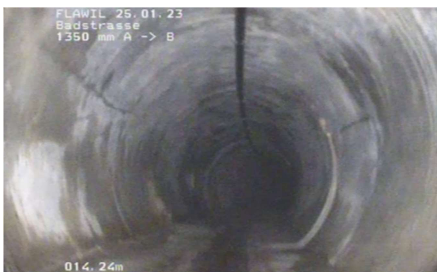
Kanalaufnahme vom 25.01.23 Wälli AG Ingenieure April 2023
