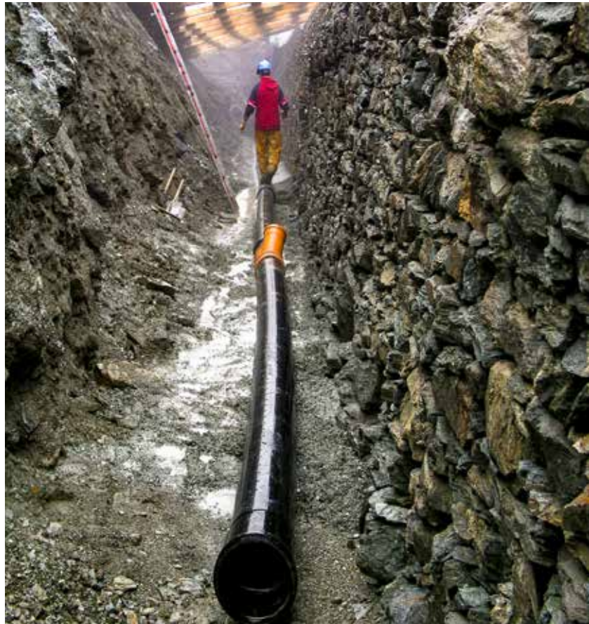
Die Entwässerung – hier ein neues Drainagerohr – ist von zentraler Bedeutung für die Langlebigkeit der Splüggalerie.
