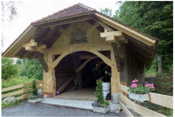
Die Hergiswaldbrücke orientiert sich streng an historischen Formen und Materialien.
