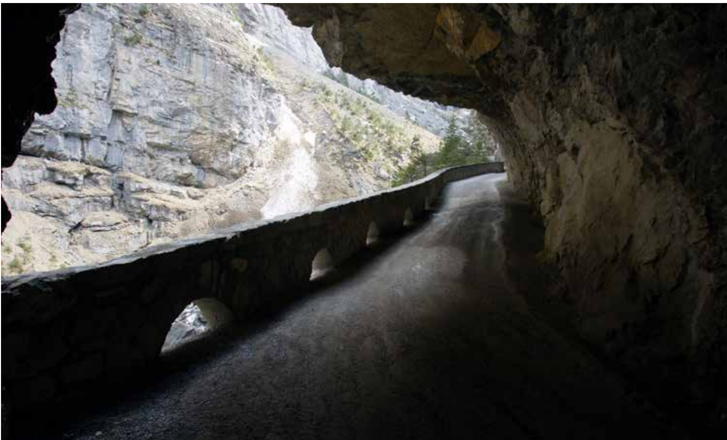
Eine Halbgalerie ist eine halbseitige Untertunnelung einer Felswand und ragt nur teilweise über die Fahrbahn hinaus. Halbgalerien sind keine Schutzbauten, sondern wurden gebaut, um eine gleichmässige Wegbreite zu erhalten. Weil sie nur die bergseitige Hälfte der Strasse vor Stein- oder Eisschlag schützen, sind sie oft selbst eine Gefahr (im Bild: Gasterntalstrasse, Kanton Bern).
