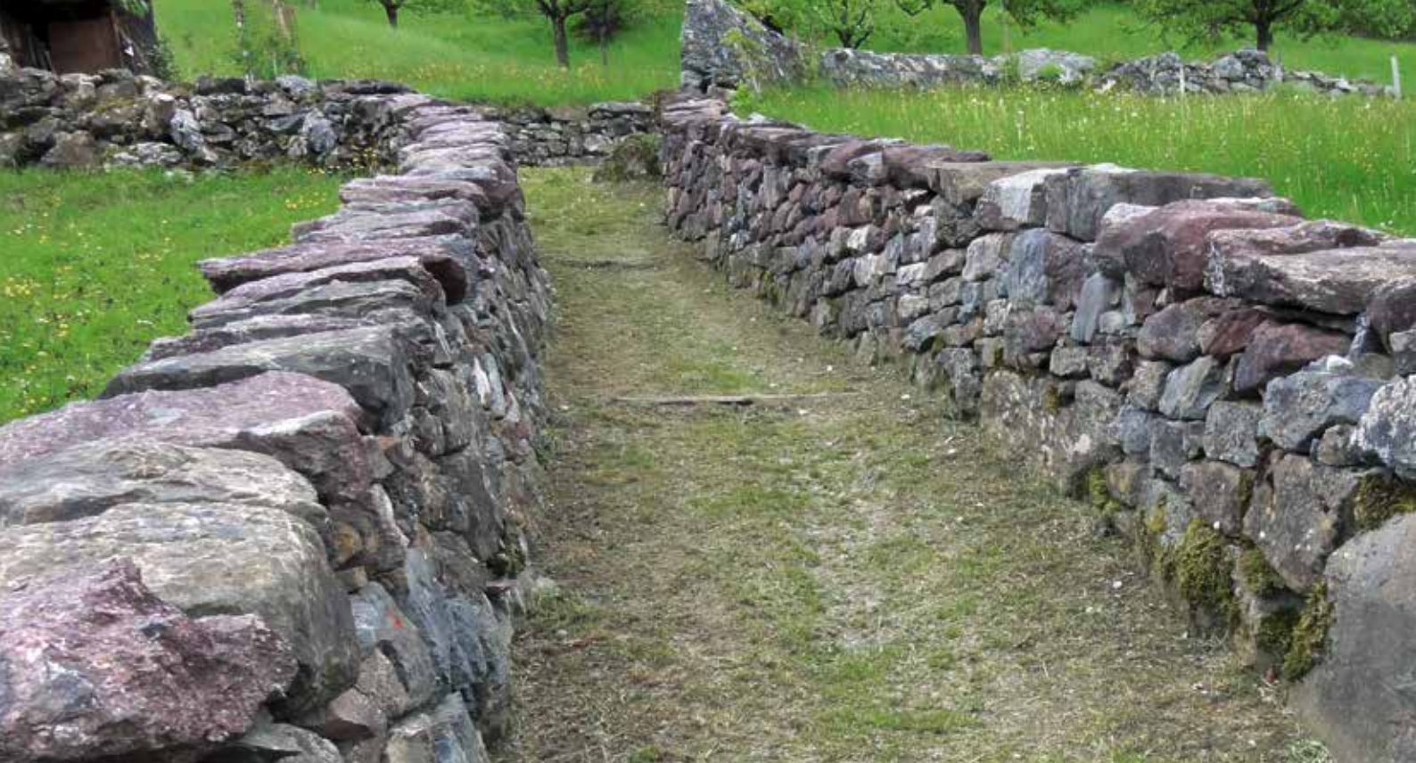
Trockenmauern am historischen Verkehrsweg von Ennenda nach Uschenberg (Kanton Glarus).
