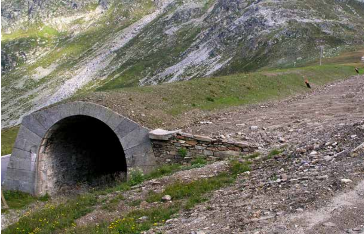
Die Lawingalerie am Splügenpass ist das einzige erhalten gebliebene derartige Bauwerk.
