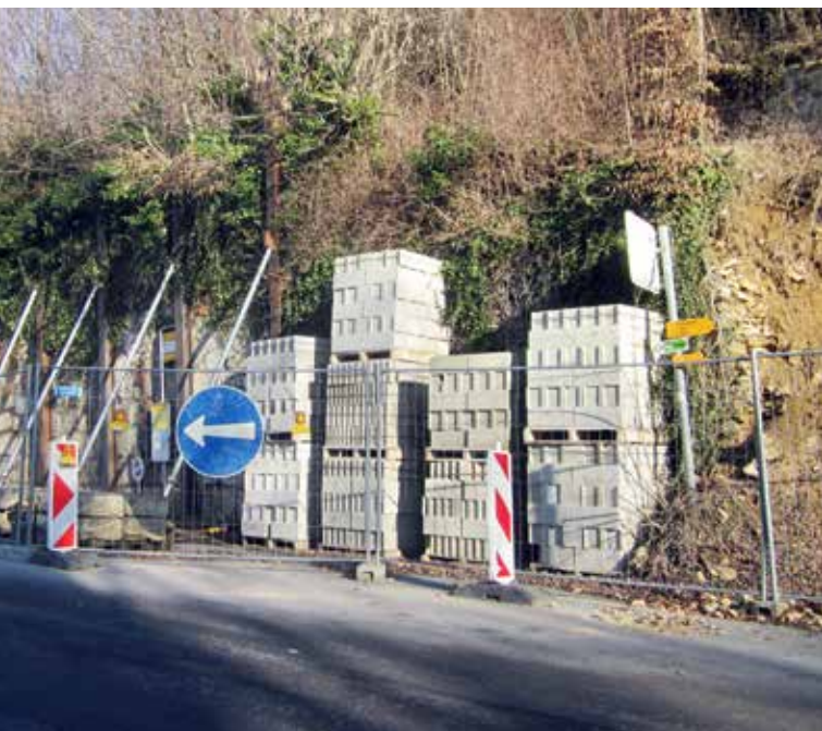
Die Sicherung der historischen Stützmauer in Romainmôtier nach dem Einsturz (links) und nach der Instandsetzung in traditioneller Bauweise (rechts).
