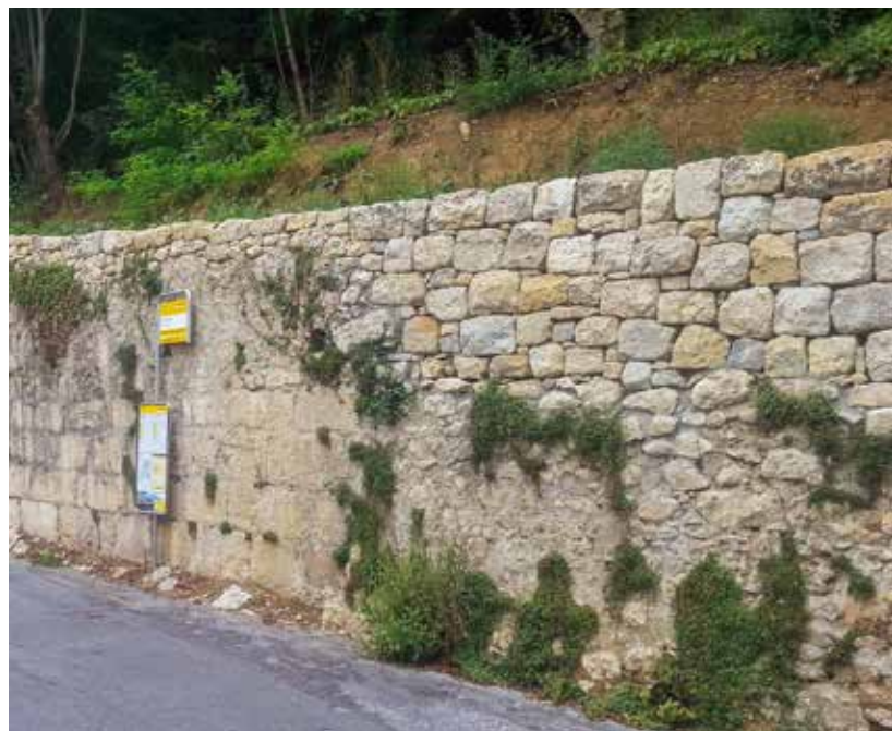
Die Sicherung der historischen Stützmauer in Romainmôtier nach dem Einsturz (links) und nach der Instandsetzung in traditioneller Bauweise (rechts).
