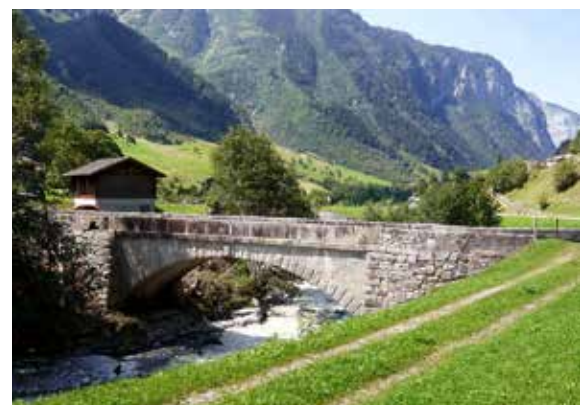
Gemauerte Brüstung auf der Bodenbrücke im Kanton Bern.
