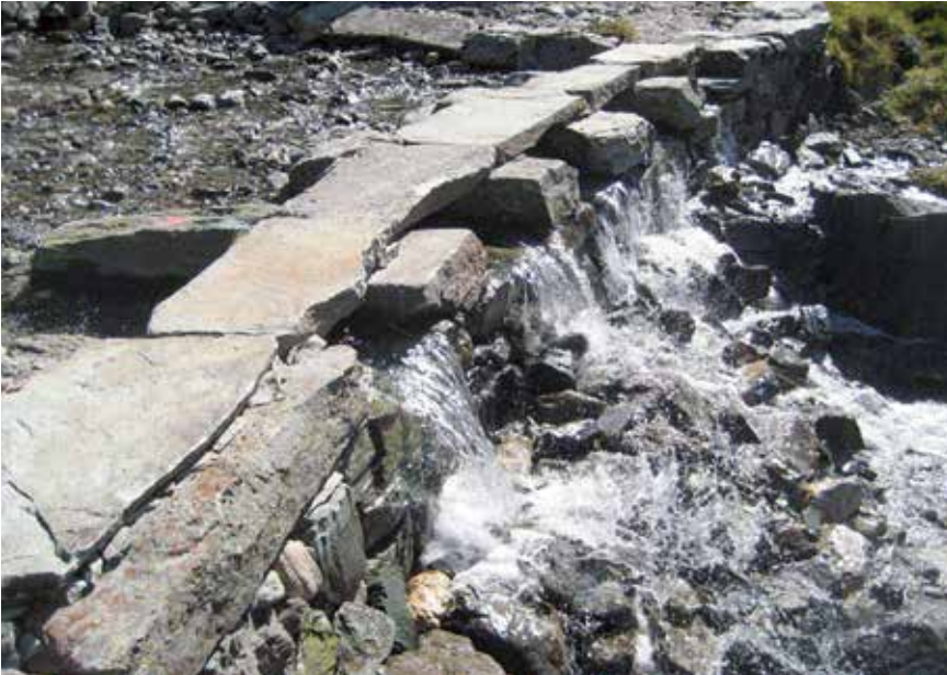
Bachübergang aus bearbeiteten Steinen am historischen Saumweg auf dem Septimerpass.
