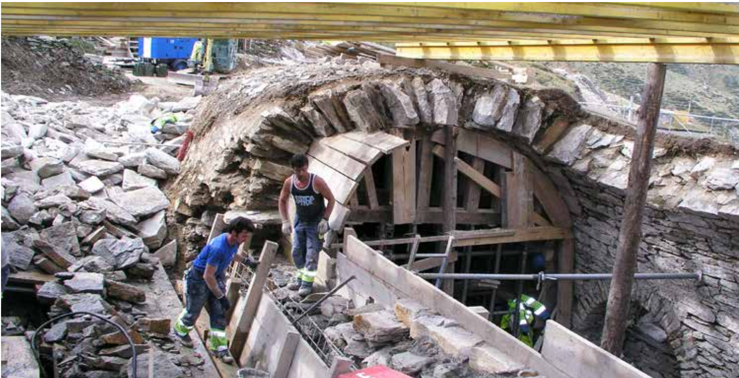
Im Zuge der aufwendigen Instandsetzung wurde die Galerie weitgehend ab- und wieder neu aufgebaut.
