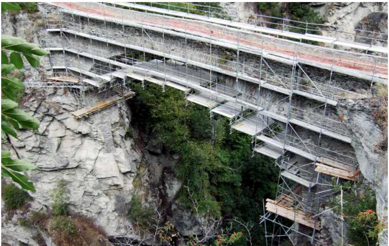
Beeindruckende Einrüstung der Chibrücke mit Abstützung auf den Brückenpfeilern.
