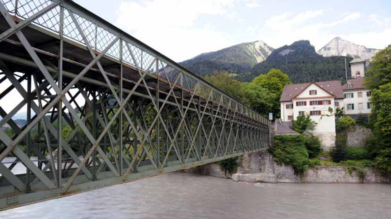
Die Rheinbrücke bei Reichenau, eine genietete Stahlkonstruktion, wurde 2014 instand gestellt.
