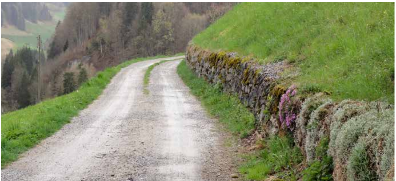
Schotter als Wegoberfläche: Instand gesetzter Güterweg Wüestenbach-Seeweide im Kanton Bern.
