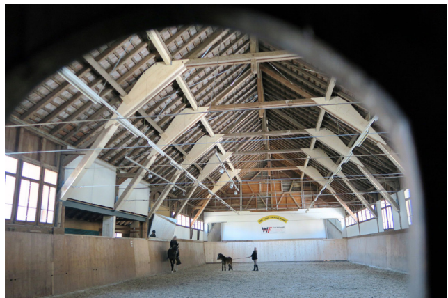
Blick in die Reithalle
