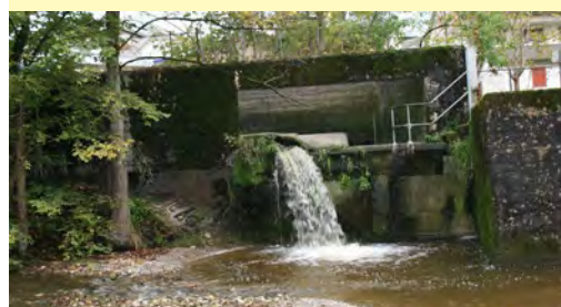
Für die Sanierung des Entwässerungssystems Töbeli sind im Jahr 2016 Investitionen von 3 Mio. Franken geplant.
