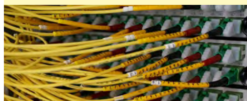
Der grösste Investitionsbrocken der Technischen Betriebe im Jahr 2016 betrifft den weiteren Ausbau des Glasfasernetzes mit 0,5 Mio. Franken.
