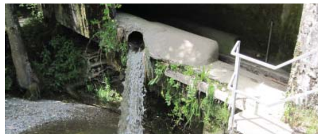
Auslauf des Dorfbachs aus dem bestehenden Rohrkanal
