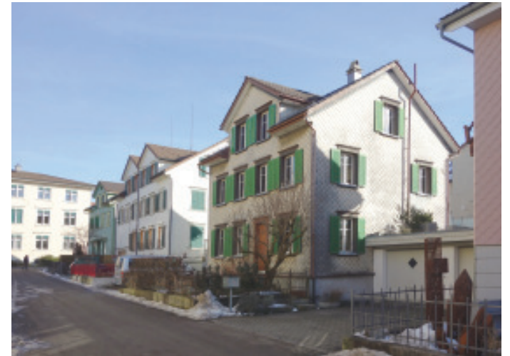
BESTANDAUFNÄHME _ STICKERHAUS AN DER NEUGASSE 10, FLAWIL
