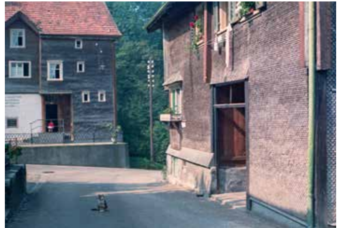
Columbanstrasse bei Gebäude 1619, im Hintergrund Gebäude 1618.
