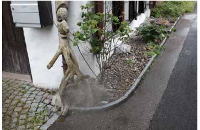
Vorbereich Haus 1620 1621: Schotterbereich durch Granitstellstein abgegrenzt. Übergang zu Parkplatz mit Granit Bogenpflasterung.
