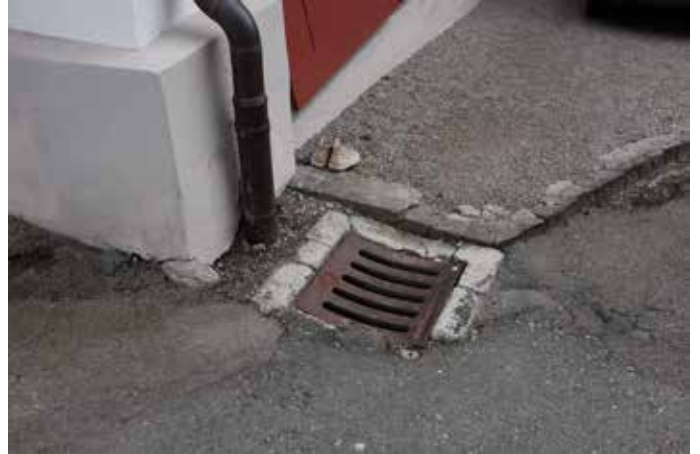
Nordwestliche Ecke Haus 1632: Schacht und privater bekiester privater Parkplatz.
