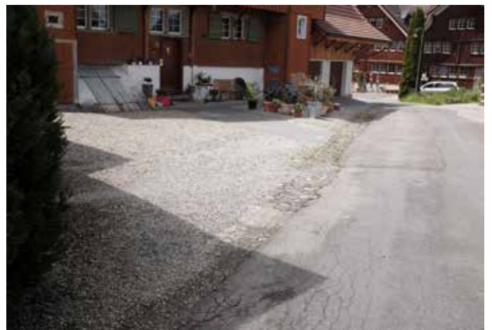
Bekiester Vorbereich ehem. Käsereigebäude.
