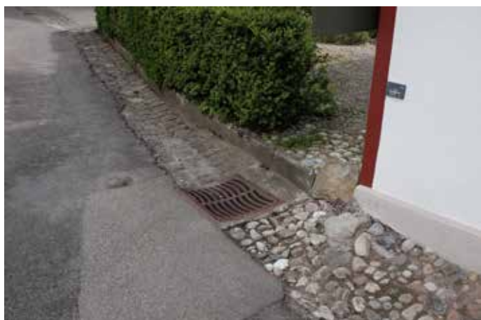
Entwässerungsrinne entlang des Gartens von Liegenschaft 1133 (Haus 1632). Der Garten wird durch einen Stellstreifen aus Betonelementen gehalten.
