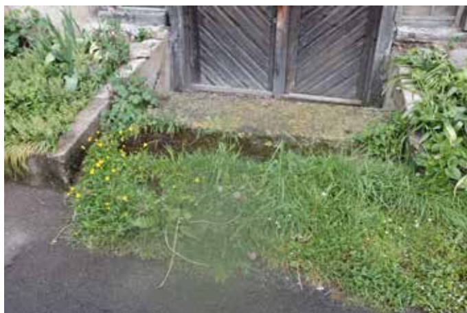
Kellerabgang bei Haus 1620. Strassenabschluss hier fragmentarisch. Gärten durch Mäuerchen gefasst.
