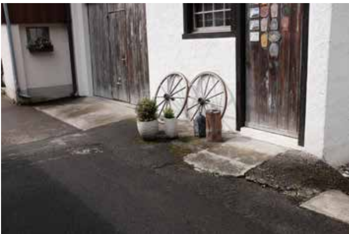
Remise 1624 bei Brunnen. Garageneinfahrt und Zugang. Betonierte Vorbereiche im Wechsel mit Bitumen. Gefälle zur Strasse und zum Brunnen.
