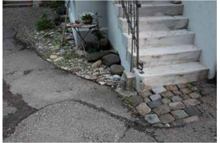
Treppe und Anschlüsse an der Ecke des Gebäudes 1637.
