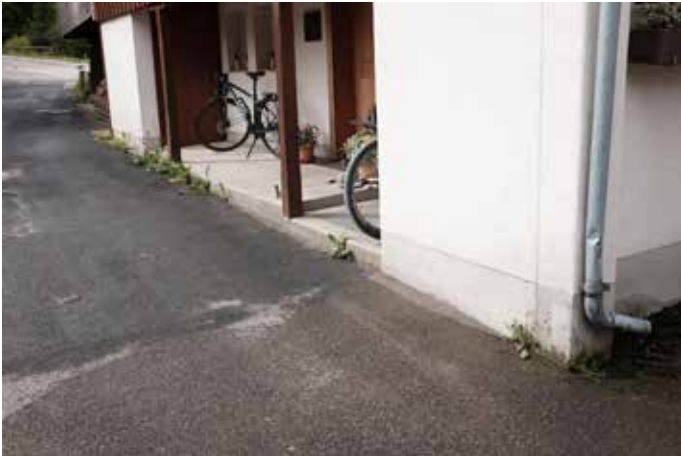
Vorbereich Haus 1623: Zurückgesetzter Zugangsbereich. Strasse bis an Fassade bituminiert.
