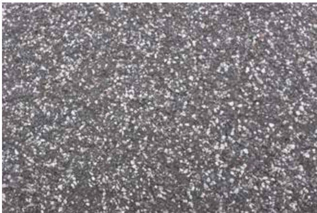
Beispiele von strukturiertem Strassenbelag: Beim Beispiel Werdenberg sieht man das Zusammenspiel zwischen strukturiertem Asphalt (links) über die Entwässerungsrinne hinweg mit einem Kiesbereich sehr gut. Unten ein ganz neues Beispiel aus der Hafencity Hamburg.
