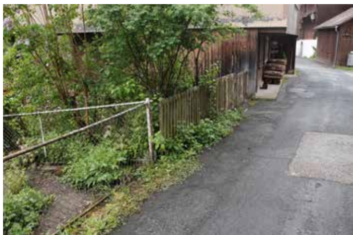
Gartengrundstücke 1138 und 1137. Betonsteine und Mauer grenzen die etwas tiefer liegenden Gärten ab. Fragmentarischer Strassenrand.
