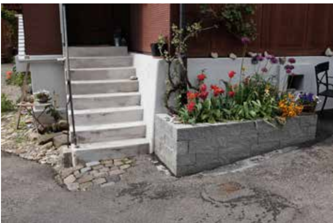
Nordwestliche Platzseite: Ecke Gebäude 1637. Treppe als Wohnungszugang, früher zugang zu einem Verkaufsladen. Pflanztrog, Pflasterung.
