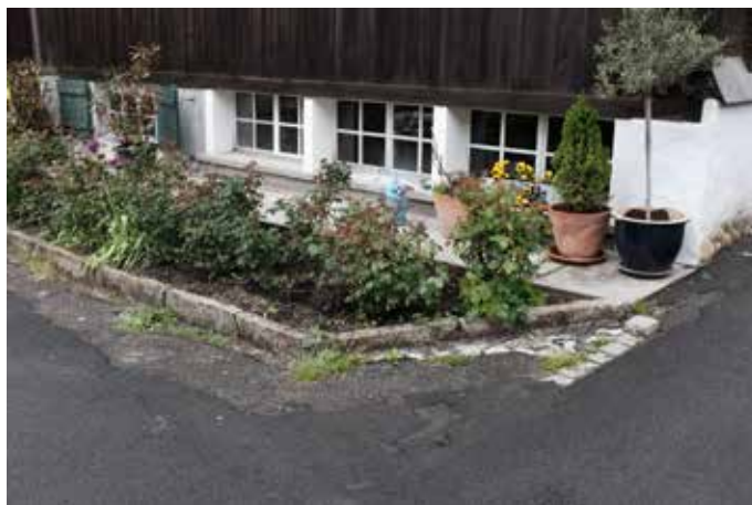
Vorbereich Haus 1619. Betonvorbereich gegossen ca. 93 cm breit, Garten mit Naturstein abgegrenzt.
