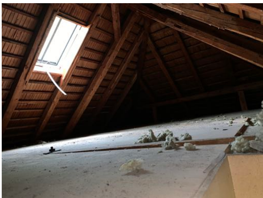
Gesägte Sparren im Mitteltrakt (Quergiebel)
