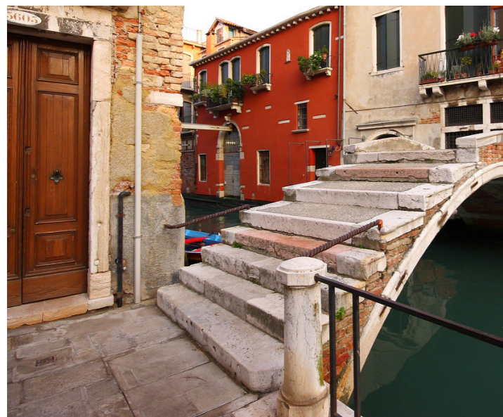
Treppenbrücke zur Überwindung des Höhenunterschieds
