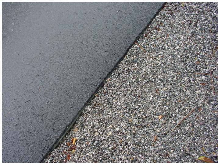
Walzasphalt und Chaussierung
