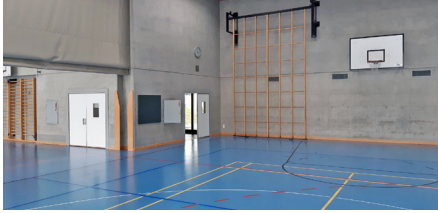
Ungeeignete winkelförmige Anordnung der Hallen 1 und 2
